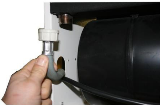
3. Enroscar la manguera de condensado ( \frac{3}{4} " )
